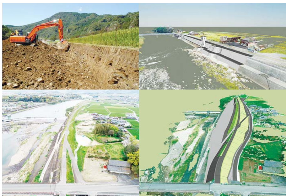
初チャレンジした築堤工事モデル（右上）と現在取り組む築堤護岸工事モデル（右下）
