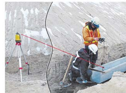
④ トータルステーションによる精度確認
